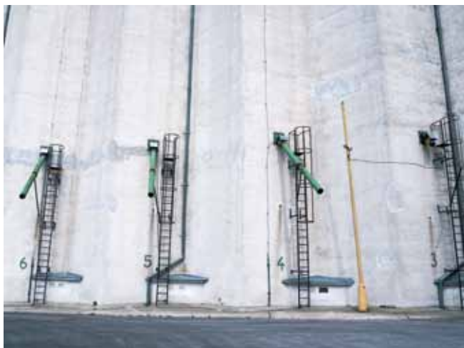
Čiastkový pohľad na zónu s bočnými výpusťami, tzv. silosmi, na vyskladňovaní zrnín samospádom. 14 silosov, jeden pre každú perifernú bunku.
