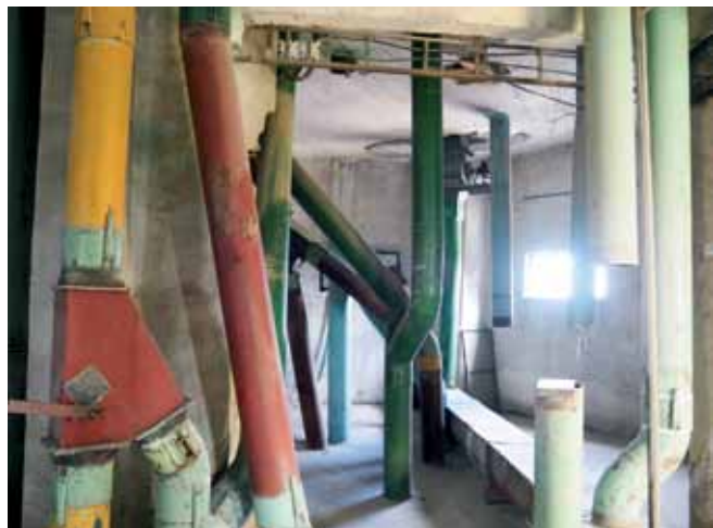
Ukážka zložitých dopravných ciest obilného sila.
