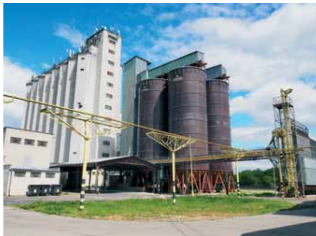
Pohľad na sústavu síl z juhu, v popredí nadzemný plynový potrubný most sušičky uložený na ocelovej konštrukcii.
