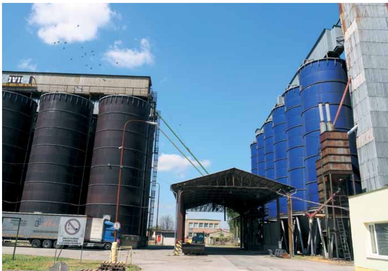
Areál RWA SLOVAKIA na Dielenskej ulici v Malackách pohľad od vstupnej brány, vpravo modré silá z roku 1972 s kapacitou 4 800 ton, vľavo hnedé z roku 1984 s kapacitou 10-tisíc ton.
