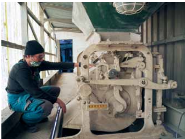
Vladimír Danihel, vedúci sila Malacky, pri dávkovacej váhe slúžiacej pre plnenie železničných vagónov.
