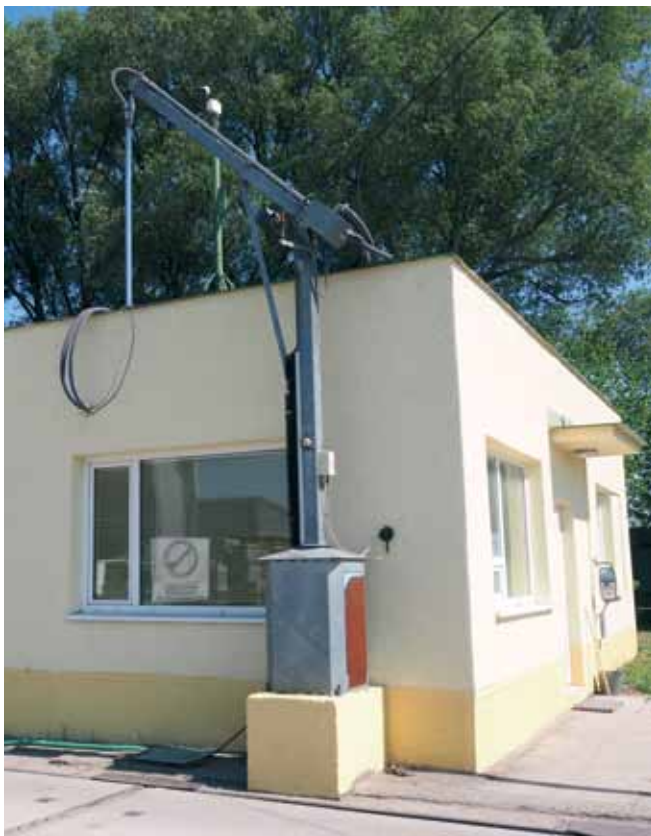
Budova pri vstupnej bráne slúži zároveň ako vážnica, laboratórium pre kontrolu kvality a vrátnica. V pravej časti budovy vidíme odbernú časť vzorkovacieho zariadenia RAKORAF.
